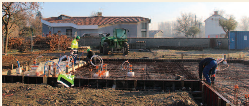
Début des travaux de la micro-crèche intercommunale.
